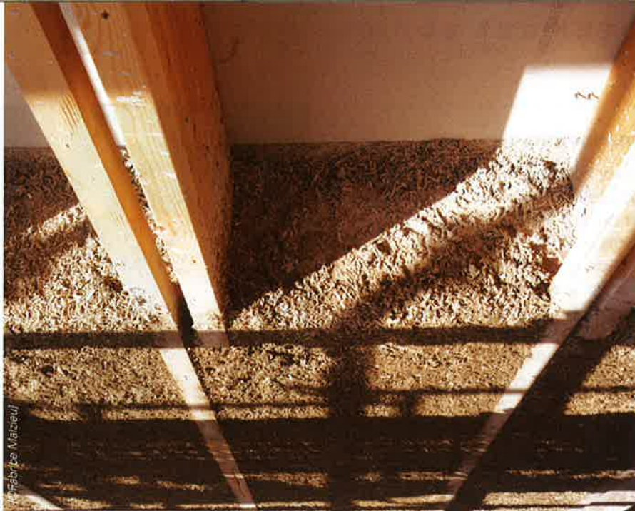
Près d'un mois a été nécessaire pour le flocage du béton de chanvre sur toutes les façades. Vue en contre-plongée
